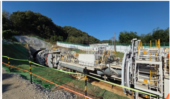
〈OPEN TBM 장비〉
